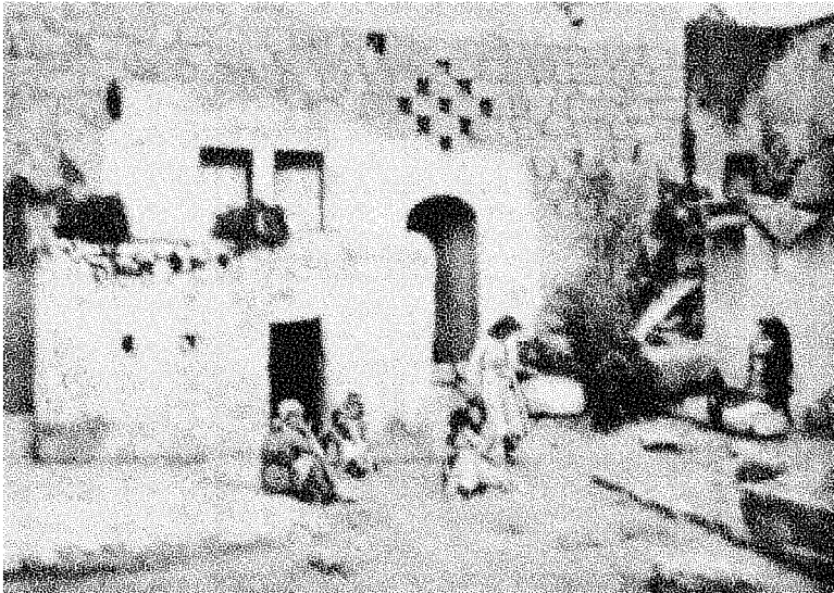
57. منظر بيت في عرابة البَطّوف، الجليل الأسفل، ص 146. فوق الباب ذي القوس كوّات تسع، إلى اليسار نافذتان، في الأمام ربما مطبخ، إلى اليمين مصطبة صغيرة وربما كوخ خبز، وعلى السطح عليّة صغيرة. (عدسة: المرحوم ف. شفويل)
