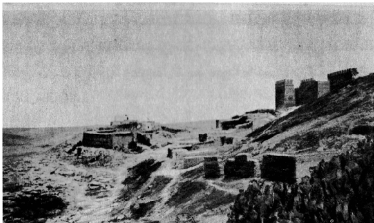
CASBAH TADLA. — PARTIE SUD-OUEST DE LA CASBAH
